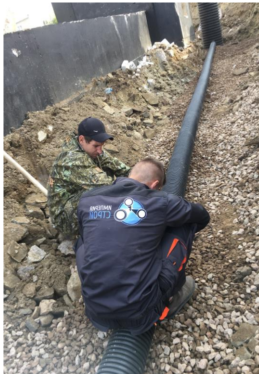
Фото 1. Строительство безнапорной хозяйственно-бытовой канализации в п. Серебряный Бор (Нерюнгринский район).
